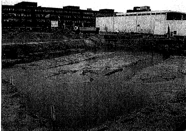
Figuur 12: Eladdiepte ontgraving (tot onder grondwaterspiegel)
