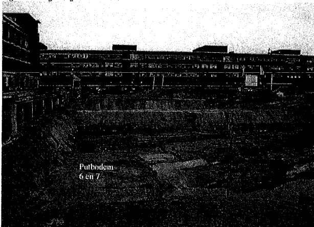
Figuur 8: Ontgraving zuidzijde tegen locatie E2
