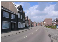
Lintbebouwing langs de Nieuwstraat
